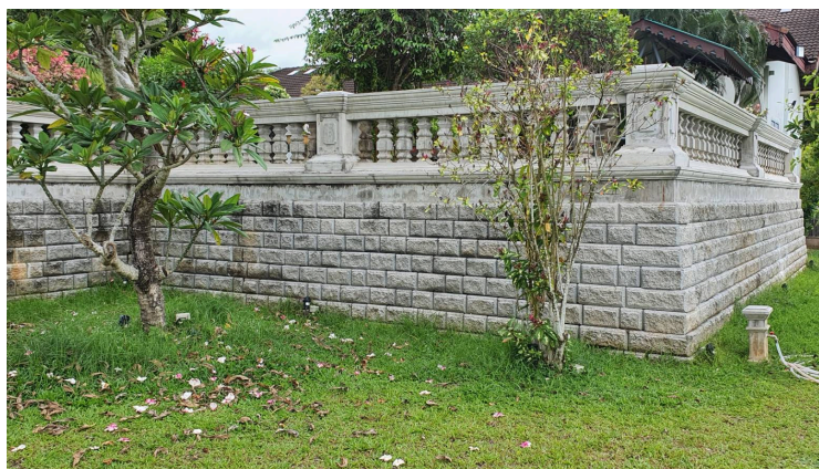
งานบ้านพักอาศัย — กำแพงกันดินที่กลืนไปกับงานภูมิทัศน์
