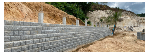
ขึ้นกำแพงเป็นชั้น ทำงานได้เร็วหน้างาน
